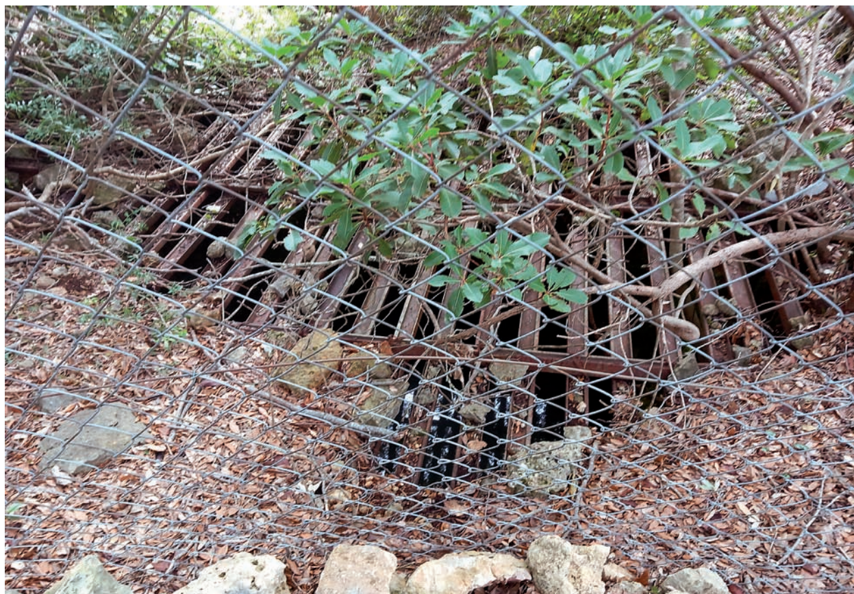
Pozzo 3 - GPS 675922.13 E - 4749221.42 N
