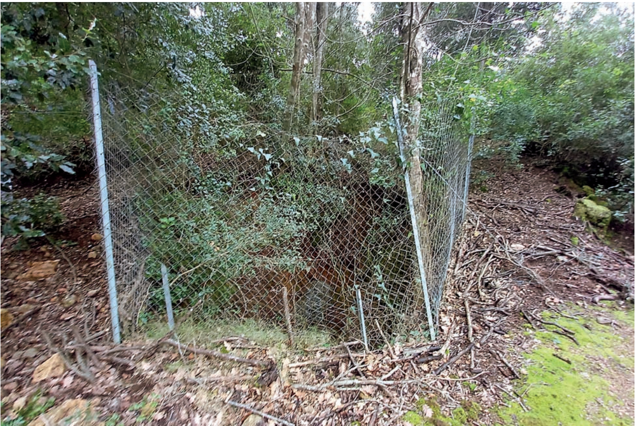
Pozzo 2 - GPS 675853.10 E - 4749346.21 N
