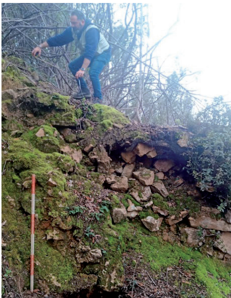
Sezione di un murale in una zona in cui è crollato parzialmente e blocco di anagenite lavorato con le coppelle, entrambi i manufatti sono costituiti da blocchi di anageniti del Verrucano
