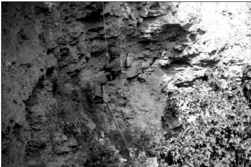
Esplorazione dei costoni di travertino nell'area di Pianizzoli.
